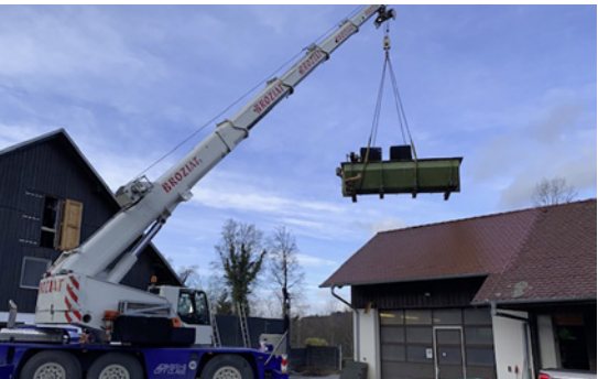
Bild 2: Ausbau der alten Kläranlage
