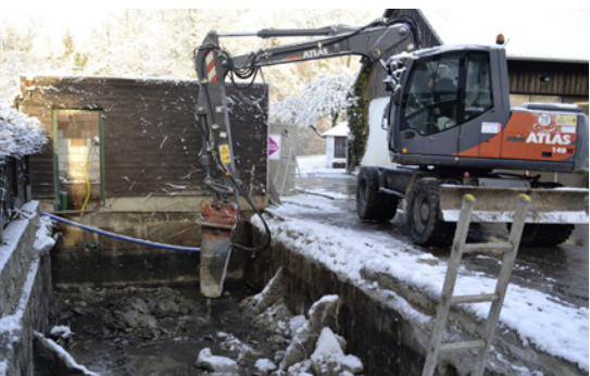
Bild 3: Freilegung der existierenden alten Klär-/Sickergrube
