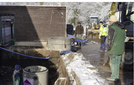
Bild 4: Einbau des Pumpenschachts
