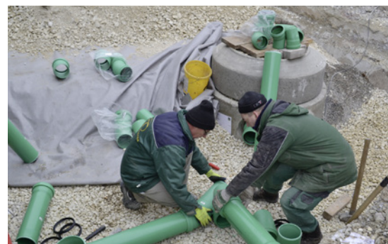
Bild 6: Anschluss der Abwasserzuleitungen und Druckleitung
