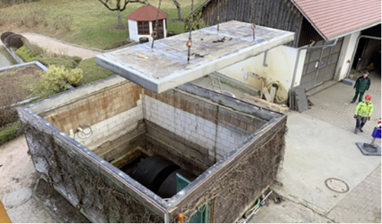
Bild 1: Dach von der alten Kläranlage abheben
